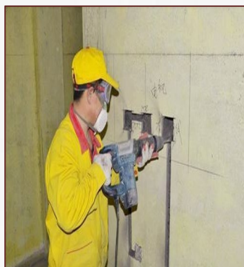
线管铺设 线盒安装
