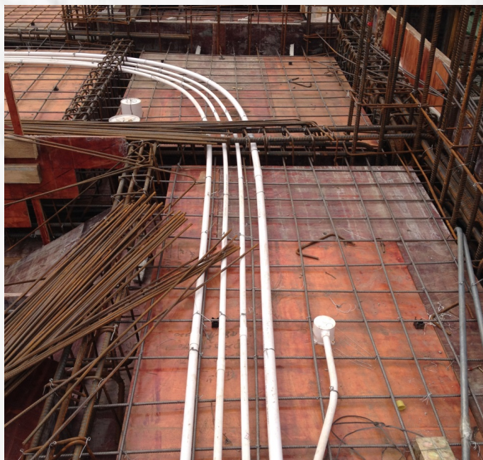
线管敷设间距规范，绑扎牢固线盒及外露管成品保护到位
