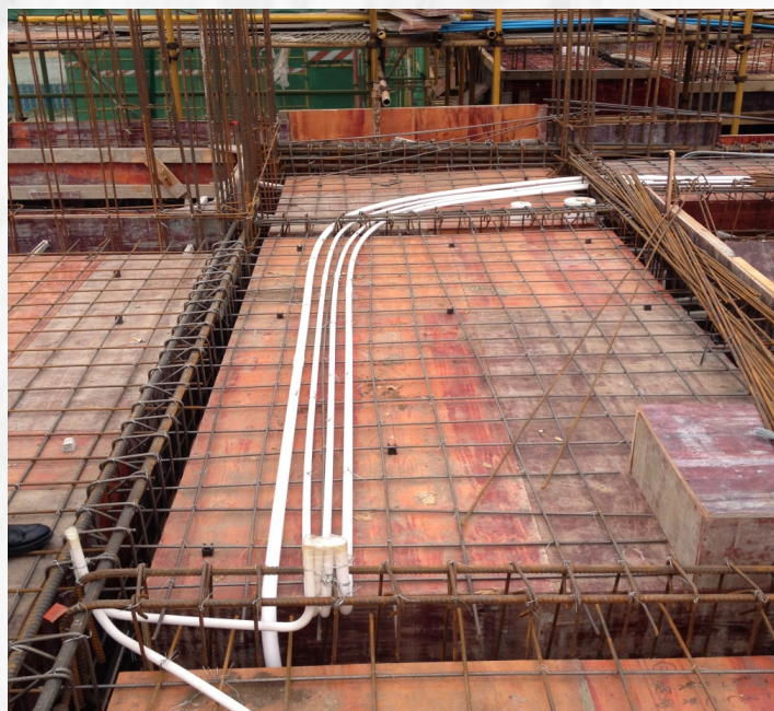
线管敷设间距规范，绑扎牢固线盒及外露管成品保护到位
